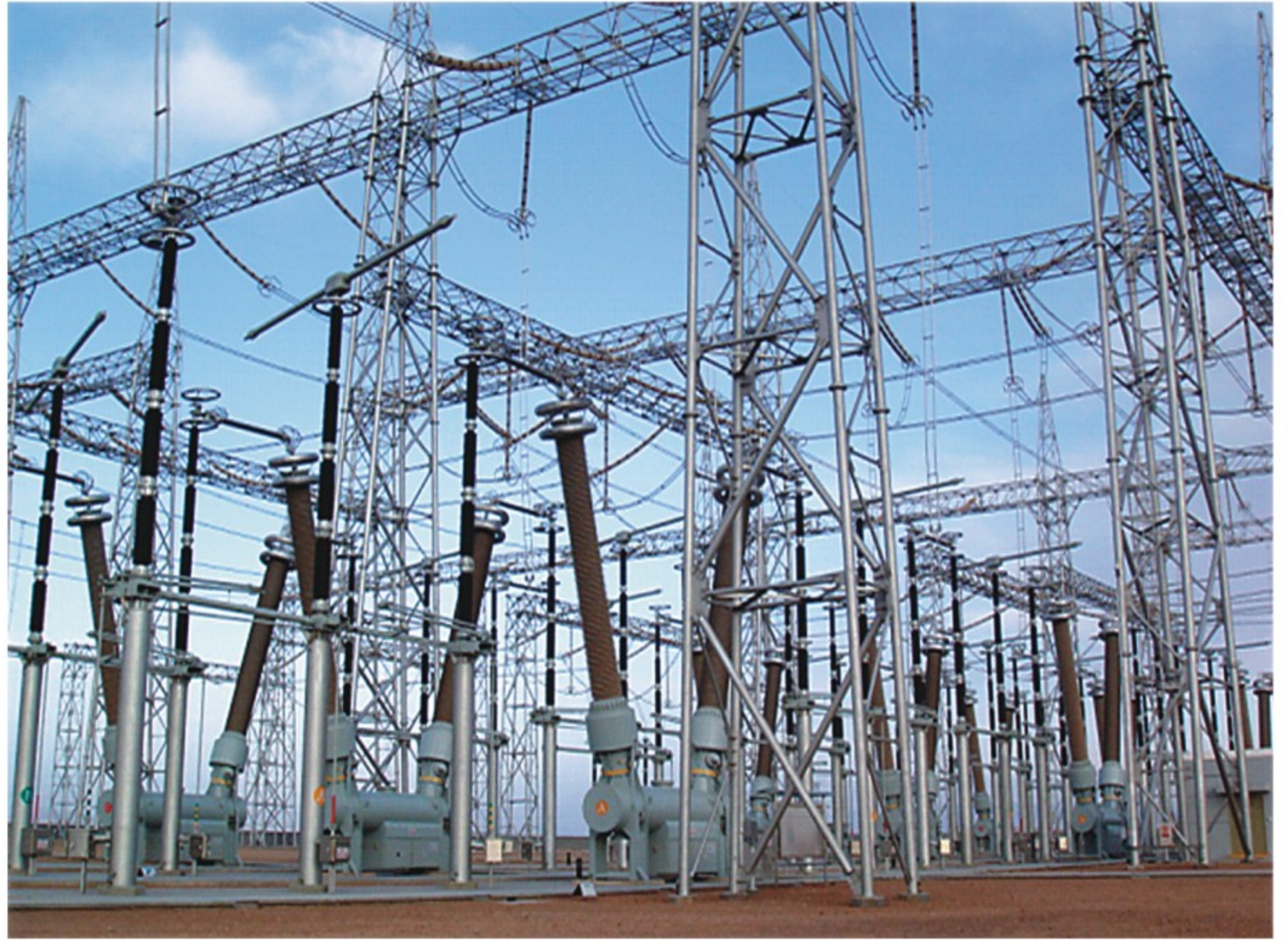
■ Выключатель элегазовый баковый типа LW55-800 для эксплуатации
