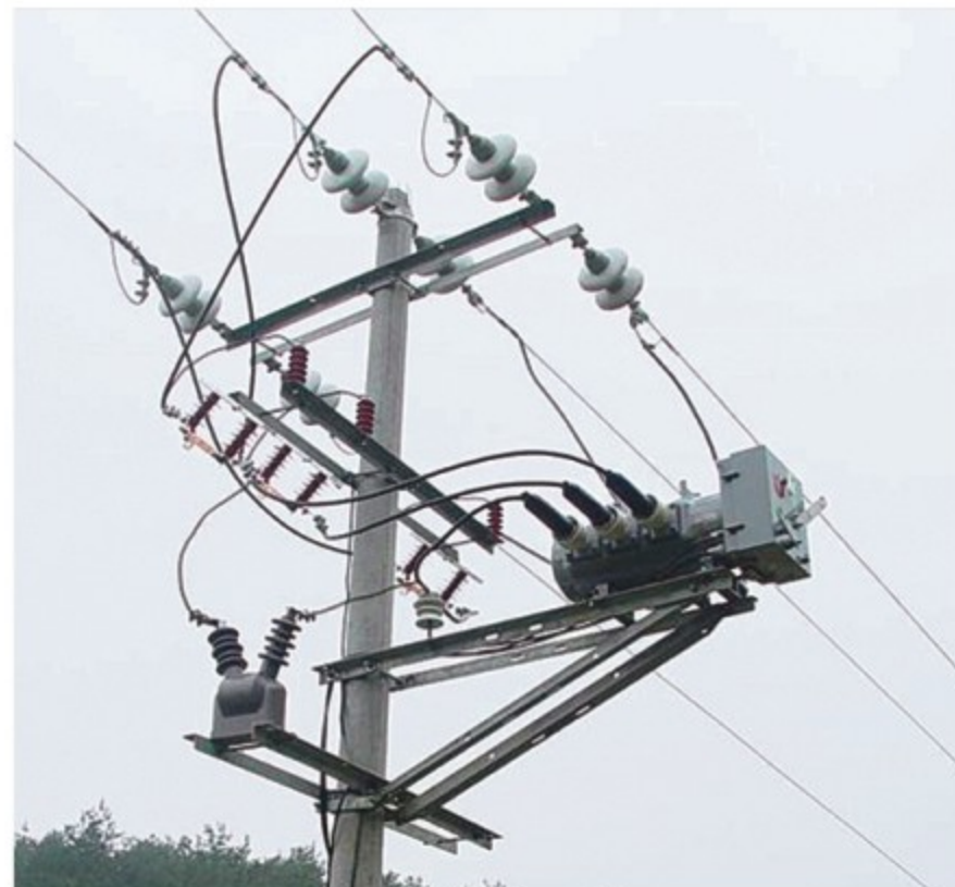
■ Выключатели нагрузки, используемые в городском округе Саньмэнься провинции Хэнань, КНР
