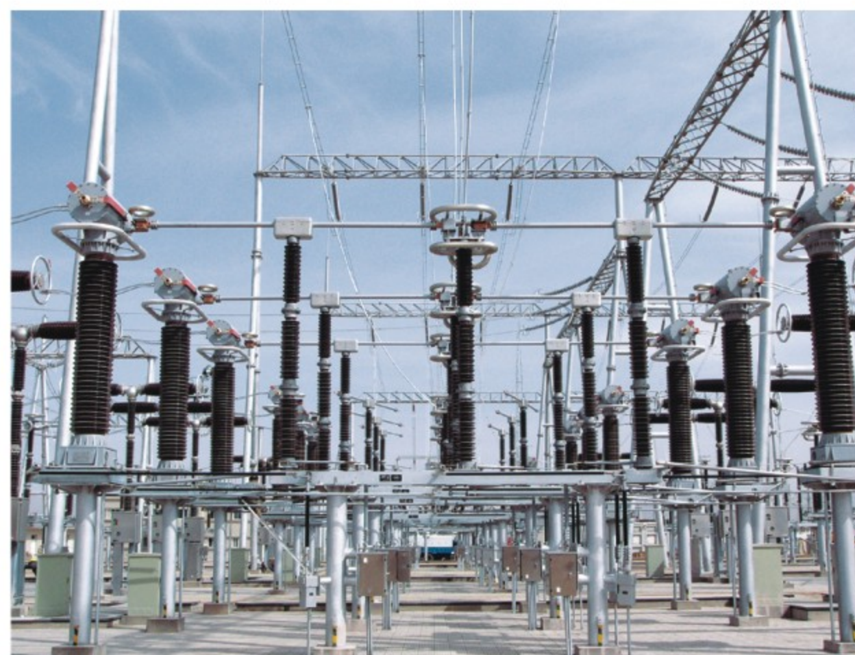
■ Разъединитель типа ZCW1-363 в эксплуатации
