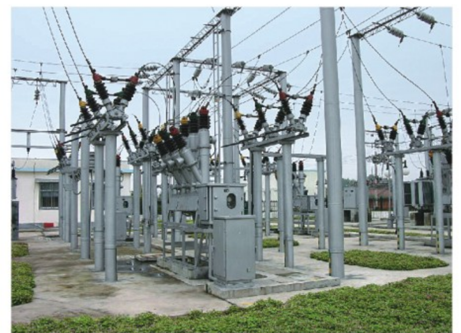
■ Разъединитель типа GW5-40.5/126 в эксплуатации
