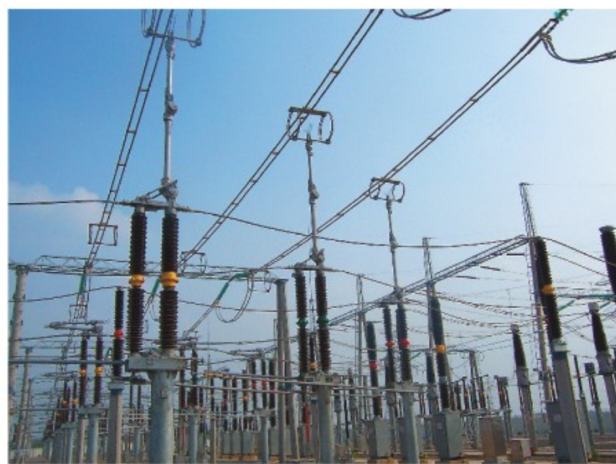
■ Разъединитель типа GW16-252 в эксплуатации
