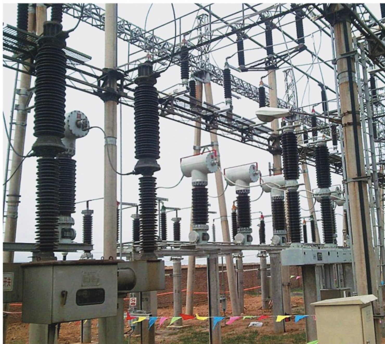
■ Элегазовый трансформатор тока серии LVQB-110 в эксплуатации
