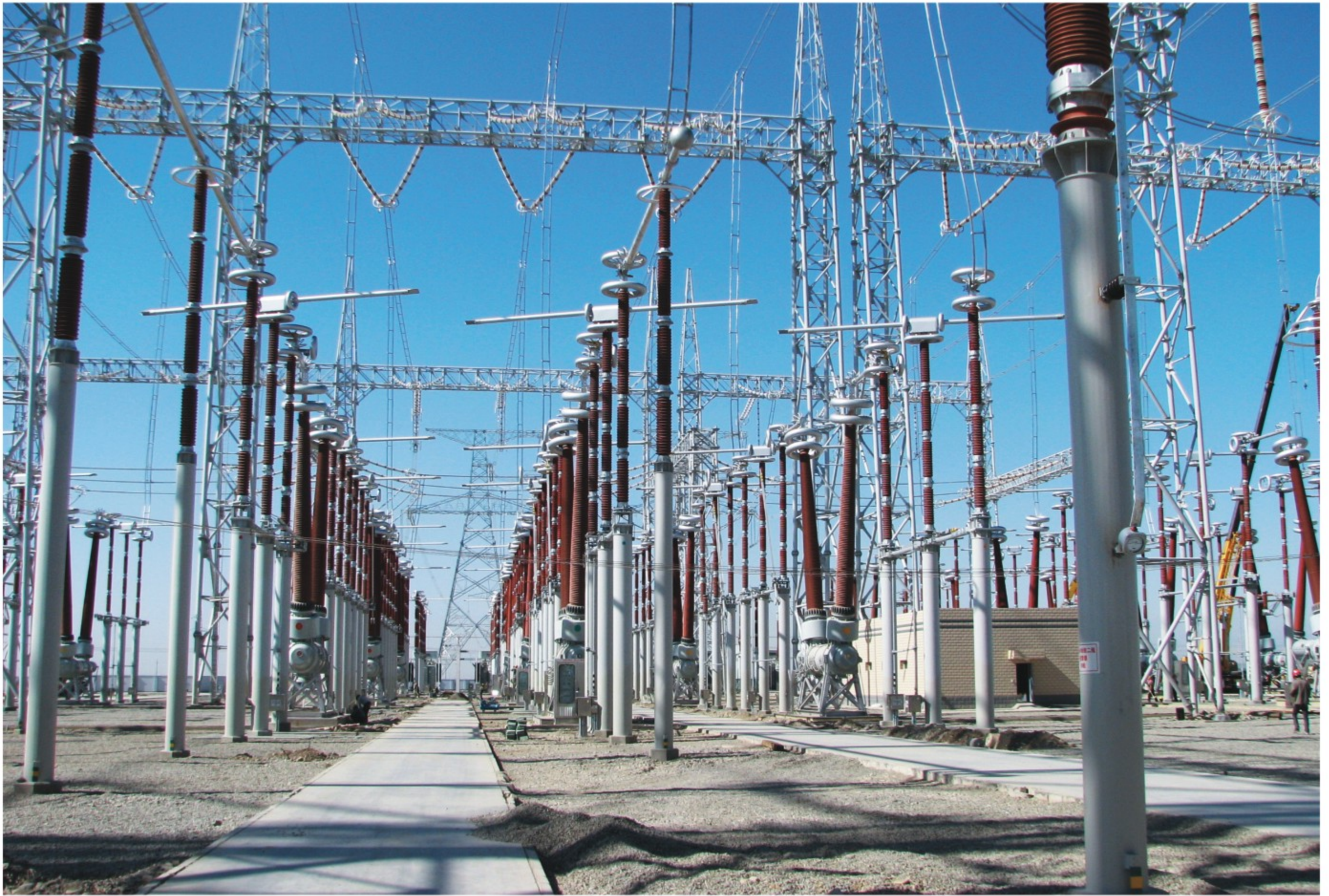
■ Разъединитель типа GW27-800 в эксплуатации
