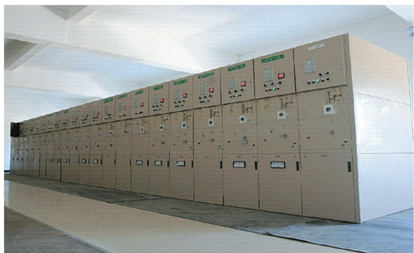
■ КРУЭ типа ZFN13-40.5(Z) кВ в эксплуатации
