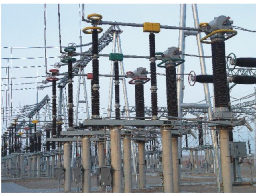
■ Разъединитель типа GW27-363 в эксплуатации
