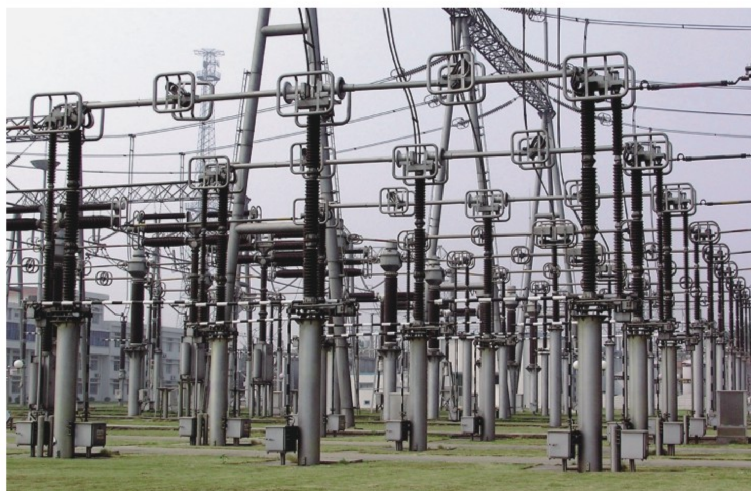
■ Разъединитель типа GW28-550 в эксплуатации
