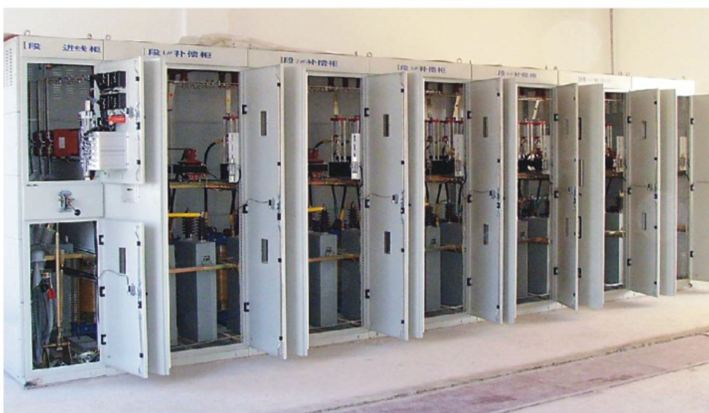
■ Установка конденсаторных батарей типа XBZZ-10 (в помещении)
