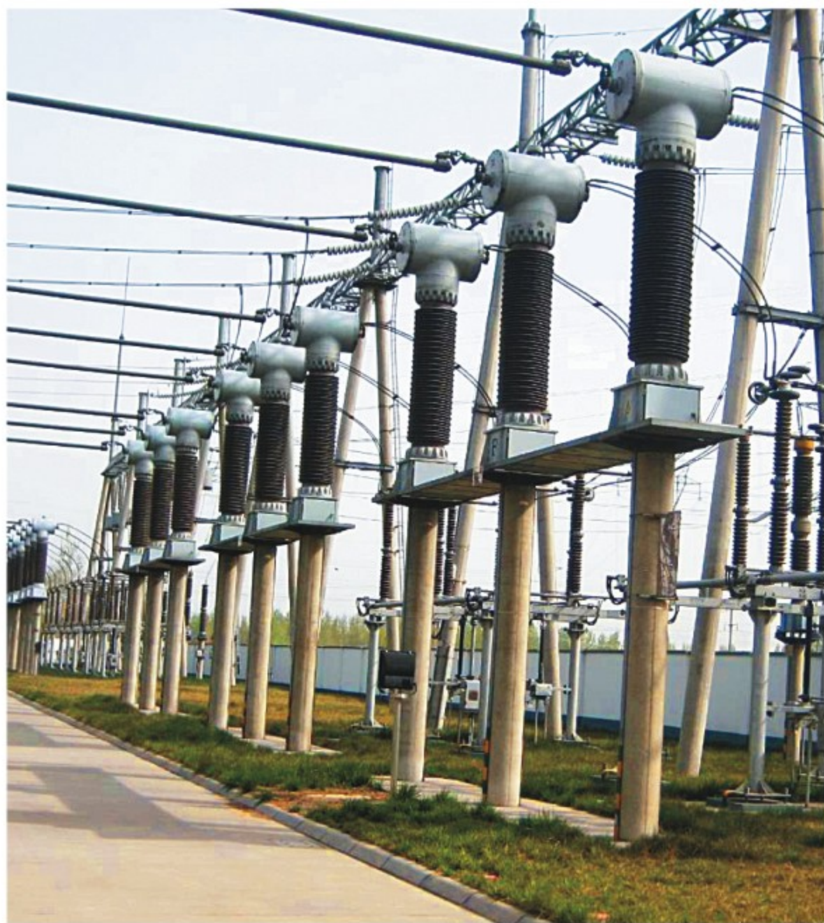
■ Элегазовый трансформатор тока серии LVQB-220 в эксплуатации
